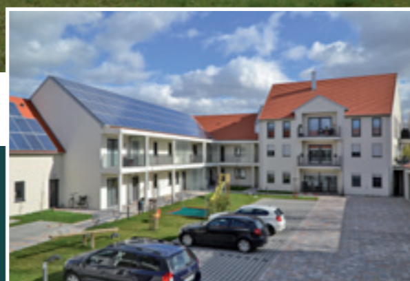
Die fertige Mühlenhof-Wohnanlage 2019.
